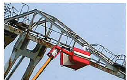
避雷針交換作業 半径30m 50Tラフター
